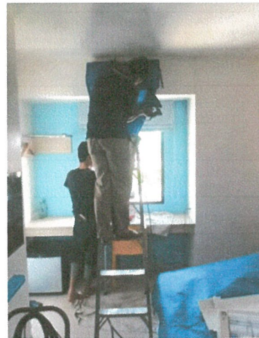
รูปภาพที่ 2.34 การล้างทำความสะอาดเครื่องปรับอากาศ
