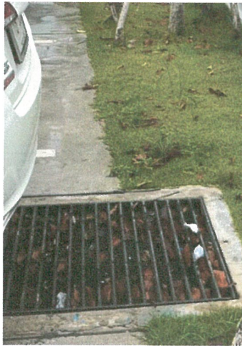
รูปภาพที่ 2.53 ตะแกรงครอบรูท่อระบายน้ำ
