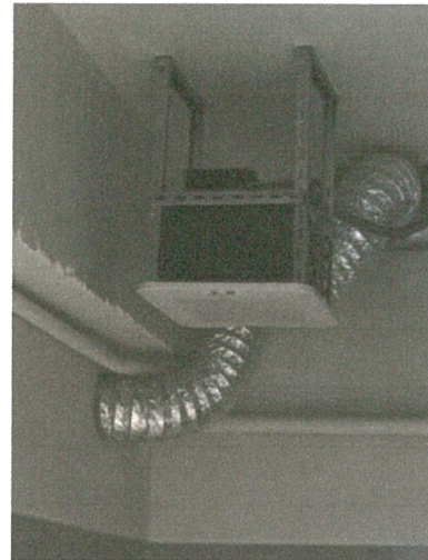
รูปภาพที่ 2.19 พัดลมดูดอากาศ
